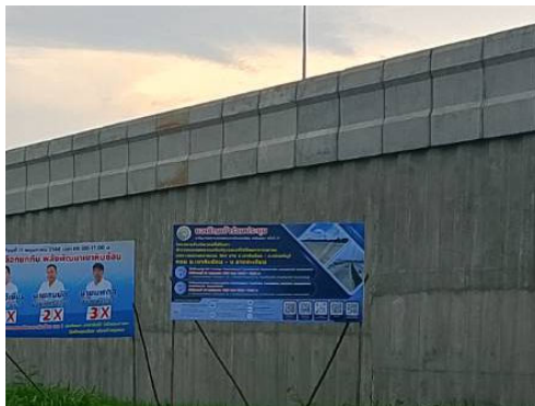
กม.126+000 บริเวณตรงข้าม ปตท เขาคันทรง
