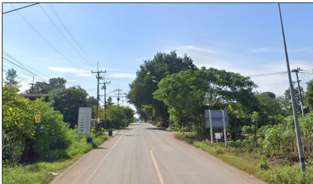
รูปที่ 6-9 สภาพปัจจุบันทางหลวงชนบท ปจ 3023
