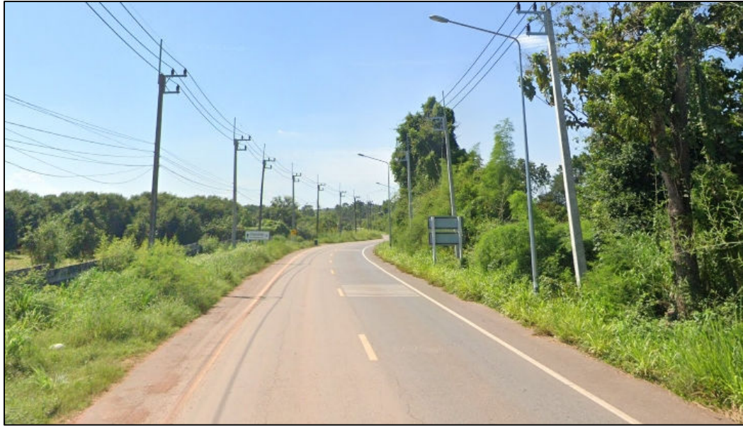
รูปที่ 6-7 สภาพปัจจุบันทางหลวงชนบท ปจ 3039
