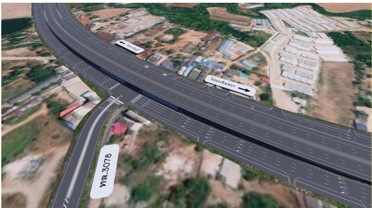
รูปที่ 7-7 ภาพทัศนียภาพทางแยกระดับพื้นบริเวณทางแยกระเบาะไฟ ที่ กม.137+304
