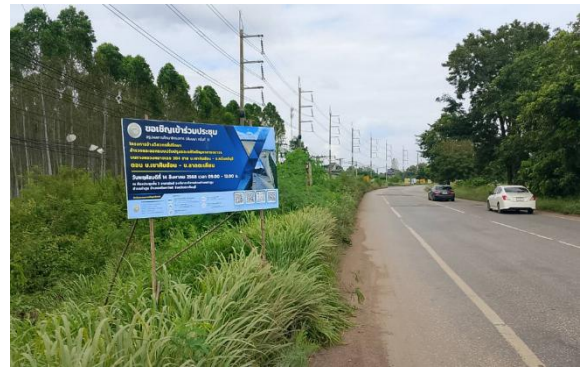
กม.147+400 สะพานข้ามคลอง
