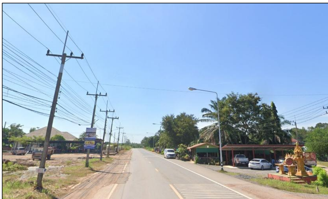
รูปที่ 6-6 สภาพปัจจุบันทางหลวงชนบท ปจ 3011
