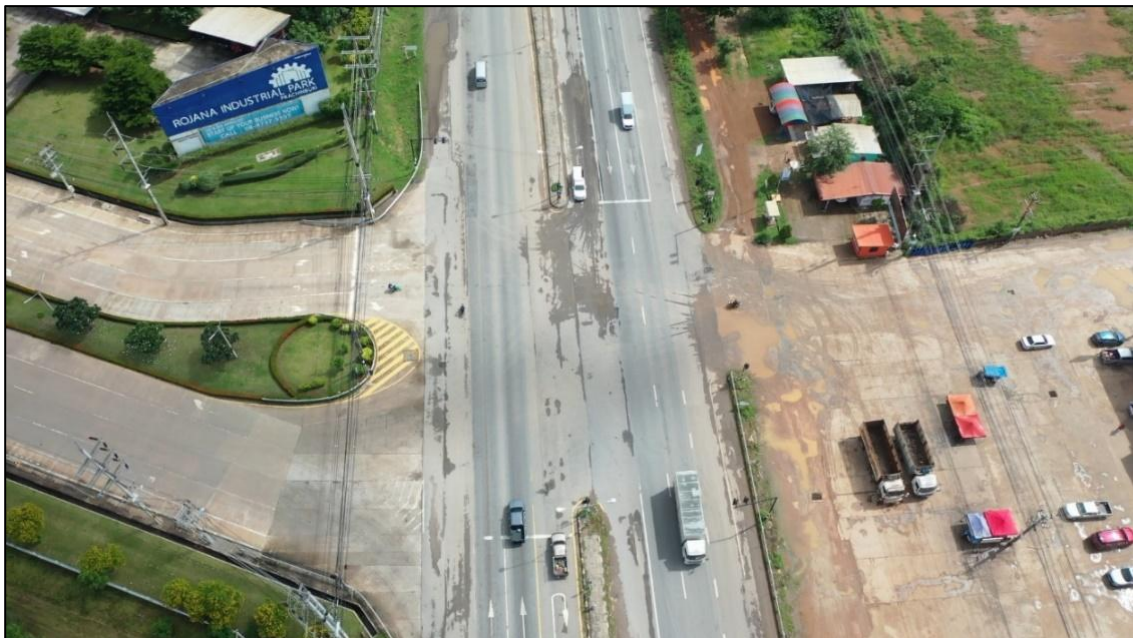
รูปที่ 6-10 ทางแยกทางเข้าสวนอุตสาหกรรมโรจนะ ที่กม. 131+750
