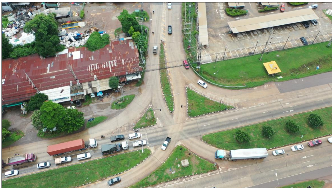
รูปที่ 6-12 ทางแยกจุดตัดทางหลวงหมายเลข 3281 หรือแยกคลองรัง ที่กม. 141+925
