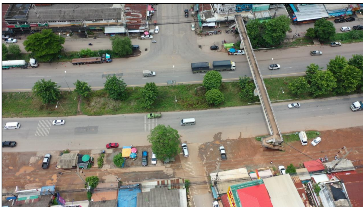
รูปที่ 6-11 จุดตัดทางหลวงหมายเลข 304 ที่ กม.142+620 กับทางหลวงหมายเลข 3079 (ขวาทง)
