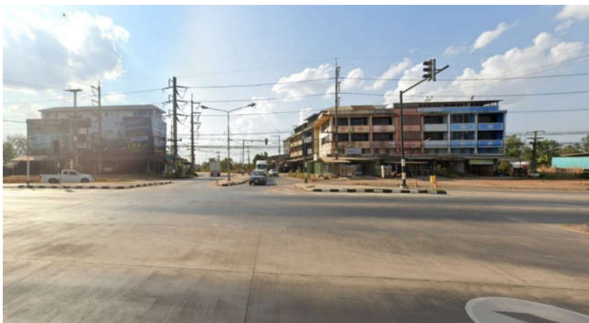
รูปที่ 8-2 บริเวณแยกระเบาะไฟ
